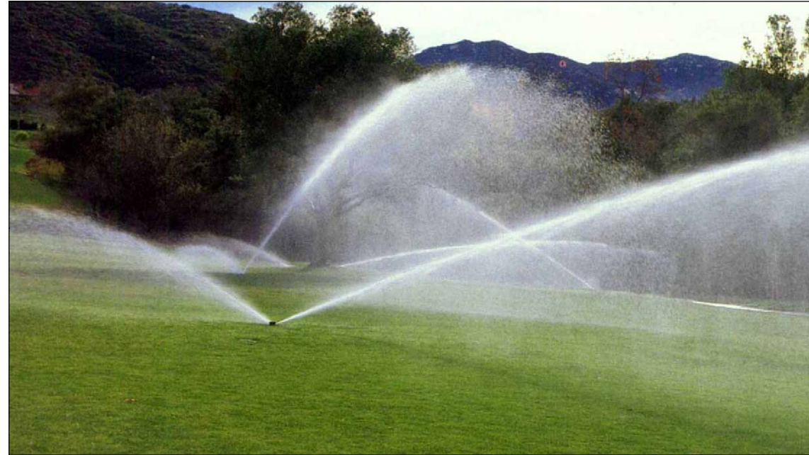
SISTEMA DE RIEGO TECNIFICADO
